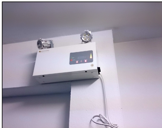
ภาพที่ 1-15ระบบไฟฟ้าฉุกเฉิน
